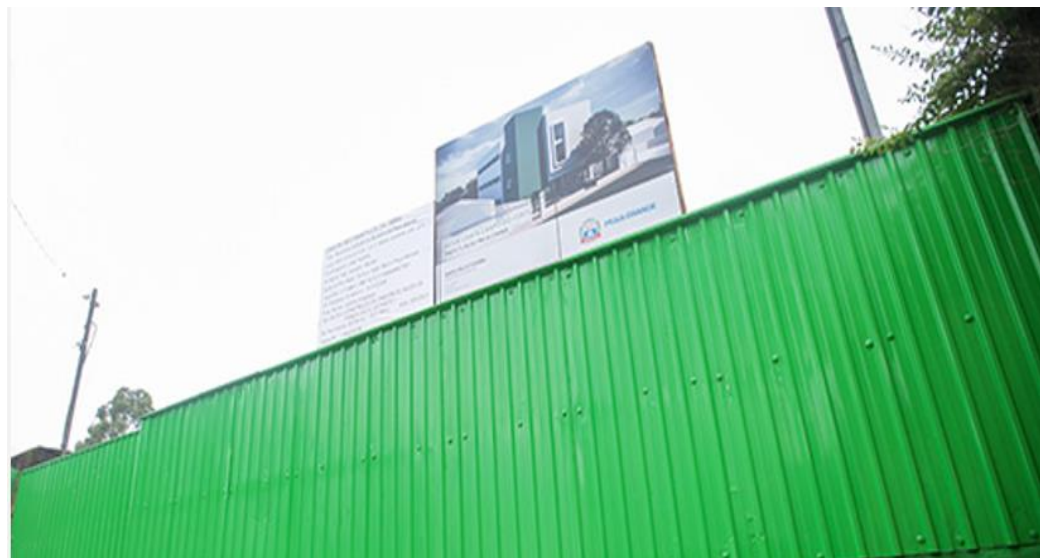
Obras da nova Usafa Xixová, no Bairro Canto do Forte Fonte: PGnotícias.
